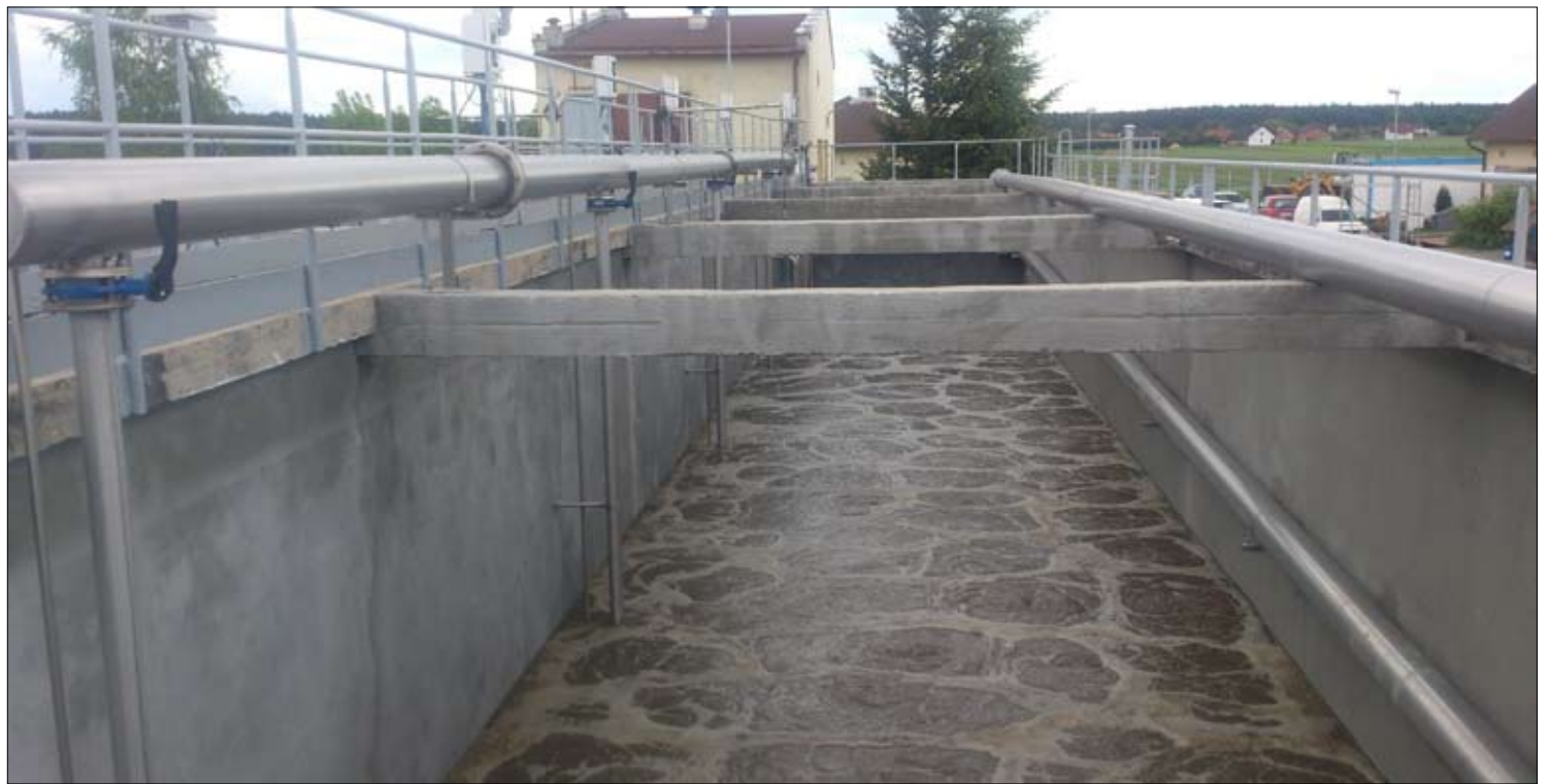
Technologia przepływowa – realizacja SADEKO 2014 r.
